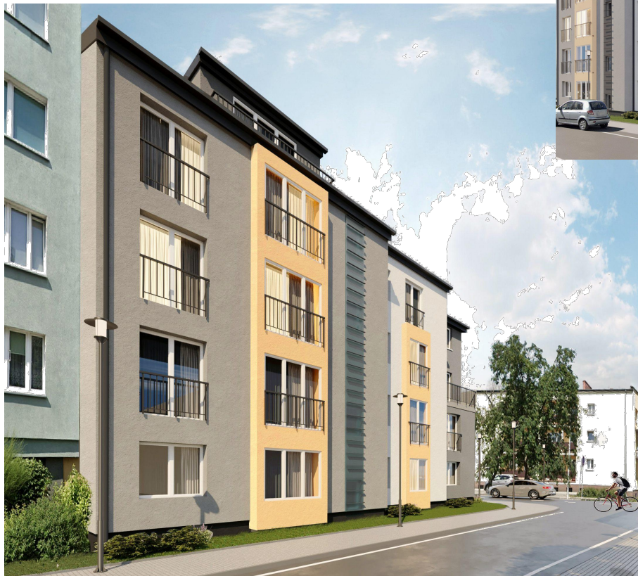
WIDOK BUDYNKU - WSCHODNI od południa
